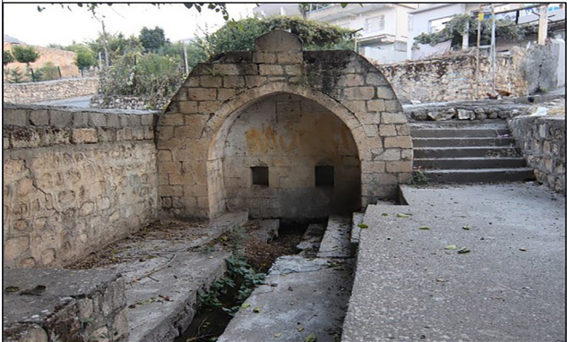
Şekil 3, Fotoğraf 5. Aynül Meydan Çamaşırhanesi ve çeşmesi (Çizim ve foto. Doğru, 2020) / Aynül Meydan Laundry and its fountain (Drawing and photo. Doğru, 2020).
