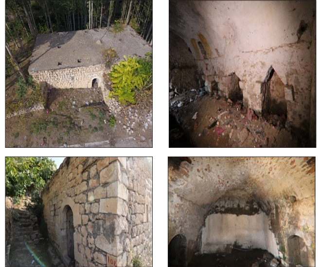
Fotoğraf 4. Çamaşırhanelerde görülen koruma sorunlarına örnekler / Examples of conservation issues typical for historic laundries (Doğru, 2020).
