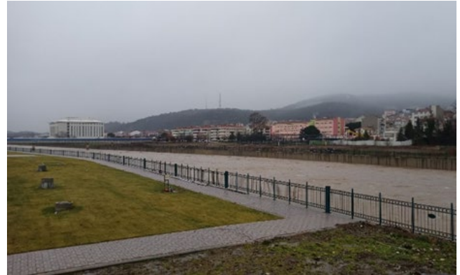
Şekil 1. Taşkın koruma çalışması olan bir bölge.
