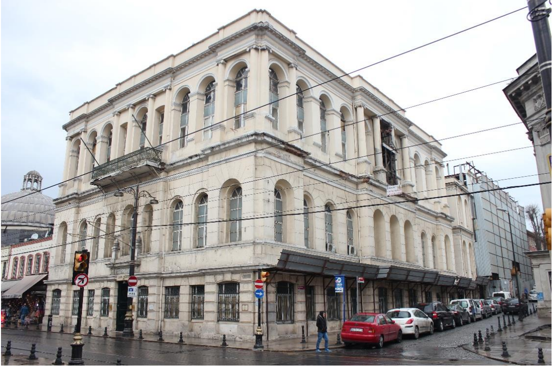
Foto. 9: Barborini'nin Divanyolu üzerinde inşa ettiği II. Darülfünun binası
