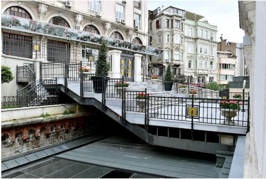
Foto. 3: 1882 yılında doğu cephenin orta kat merkezine eklenen demir köprü'nün günümüzdeki yenilenmiş durumu. (Beyoğlu Belediyesi Arşivi)
