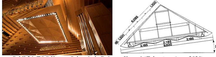
Şekil 36. TOC Konser Salonu'nda Bulunan Kanopi (Takemitsu Anıtı, 2021).
