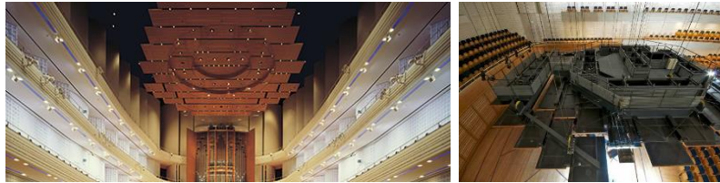
Şekil 21. KKL Konser Salonunda Bulunan Kanopi (KKL Luzern ve KKL Acoustics, 2021).
