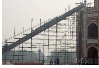
Şekil 52. Humayun Türbesi Restorasyonu (URL 11) (Figure 52. Restoration of Humayun's Tomb URL 11)
