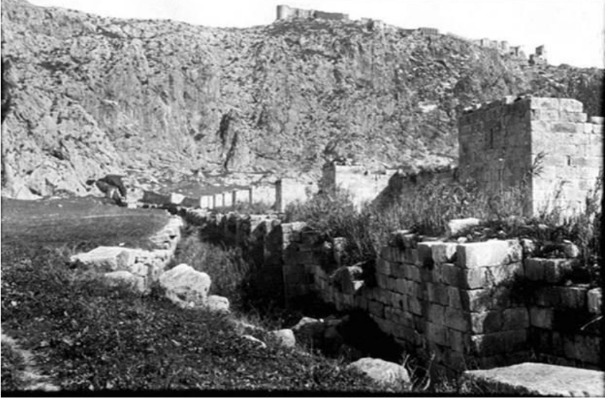
Foto.28: Kuzey Surları ve Hendek (Bell 1905)
