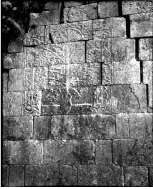
Foto.40: Batı Kapıları (Bell 1905)
