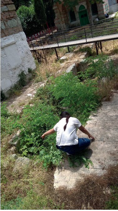
Görsel 7: Minare temeline saplanan duvar (Foto. S. Gündüz Küskü, 2019)
