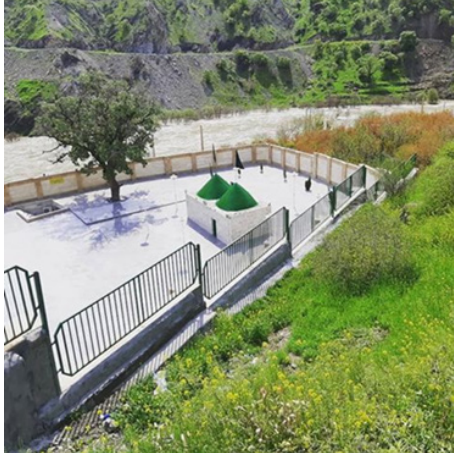
Şekil 1: Restore edilen Sultan İshak Türbesinden bir görünüm (Jazebeha, 2 Şubat 2023).
