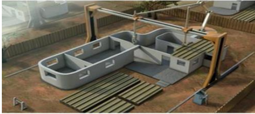
Şekil 19. Kontur üretimi sistemi, vinç uygulaması (Çelik vd., 2017) Figure 19. Contour generation system, crane application (Çelik et al., 2017)
