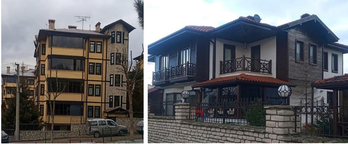
Şekil 2. Çimkent apartmanı ve Akçasu evleri Figure 2. Çimkent apartment and Akçasu houses
