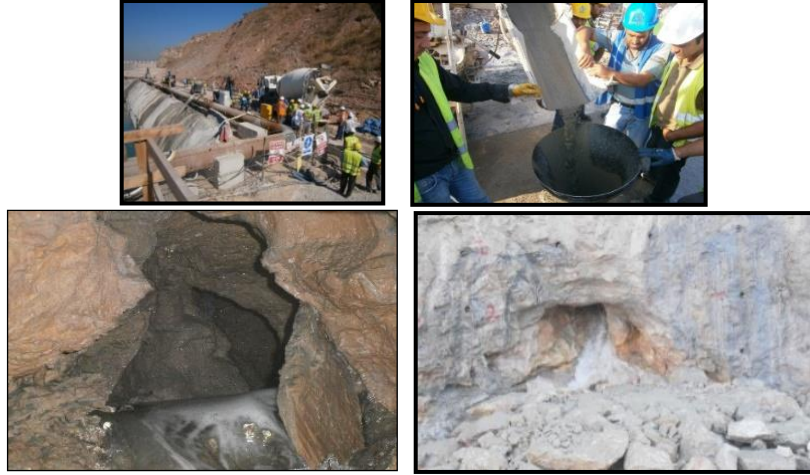
Şekil 14. Bu şekil ana yeraltı suyu giriş noktasındaki ıslah çalışmalarından alınmış
