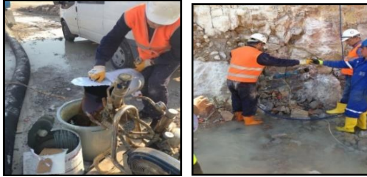
Şekil 8. Poliüretan enjeksiyon uygulaması
