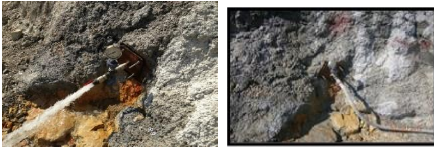
Şekil 17. Karstik boşluğa enjeksiyon uygulaması
