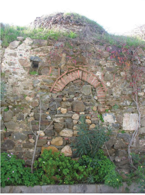
Fot. 15: 5 numaralı mekanın penceresi.
