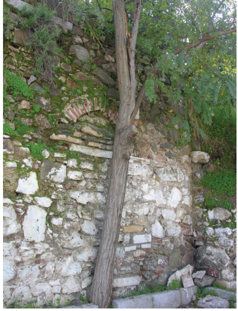
Fot. 16: 1 numaralı mekanın penceresi.
