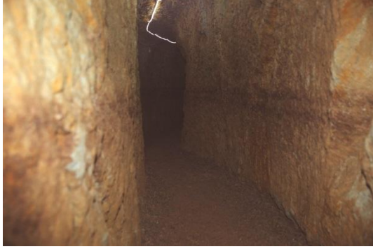
Fotoğraf – 7 (Duvar ve koridor yapısı)
