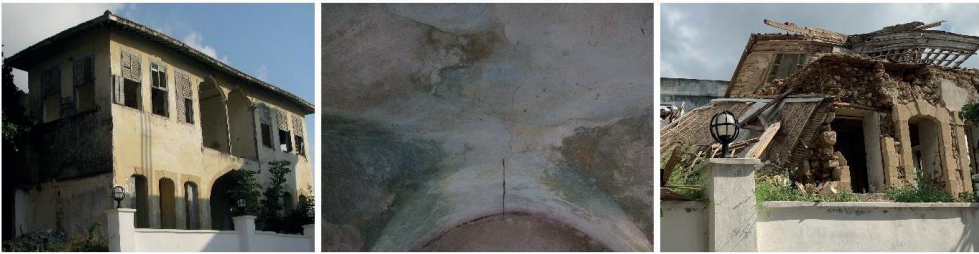
Görsel 10: Solda: Mirioğlu Konağı . (Yeşilpınar, 2014). Ortada: Aynı yapının alt katında, mutfak biriminde çapraz tonoz uygulaması. Sağda: Aynı yapının deprem sonrası durumu (02.04.2023).
