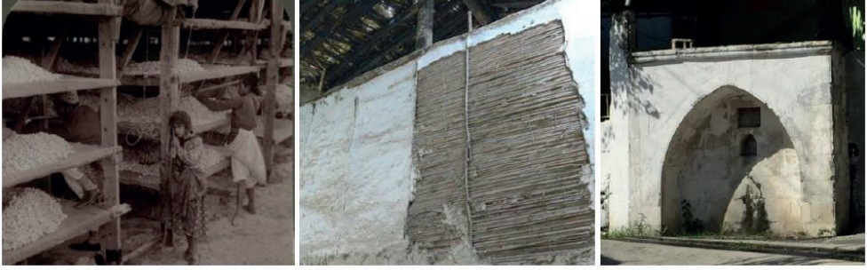
Görsel 8: Solda: Musa Dağ köylerinden birinde, üzerine ipekböceği kozaları serilmiş “şkale”. ( Mast Colection – Library of Congress, USA ) Ortada: Bêtur (hasır iskelet üzerine sıva ile yapılmış bir perde duvarı) uygulaması. (Döver - Adile Bulgurcu Evi, 2006). Sağda: Köyün çeşmesi ‘ Ayn ed-day’a ’ (Aknehir - yukarı mahalle, 2020.).
