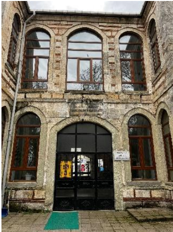
Şekil 7. Taş yığıma bölüm, giriş cephesi
