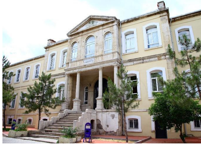
Şekil 6. Eski Harbiye Kışlası anıtsal giriş cephesi
