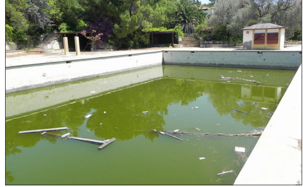
Fotoğraf-11. Ortak mekan (Yüzme Havuzu)
