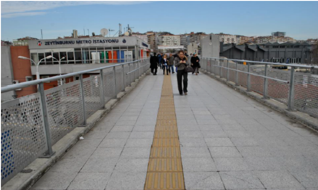
Şekil 4. Araştırmanın Yapıldığı Bölgede Yaya Üst Geçidi Görüntüsü.
