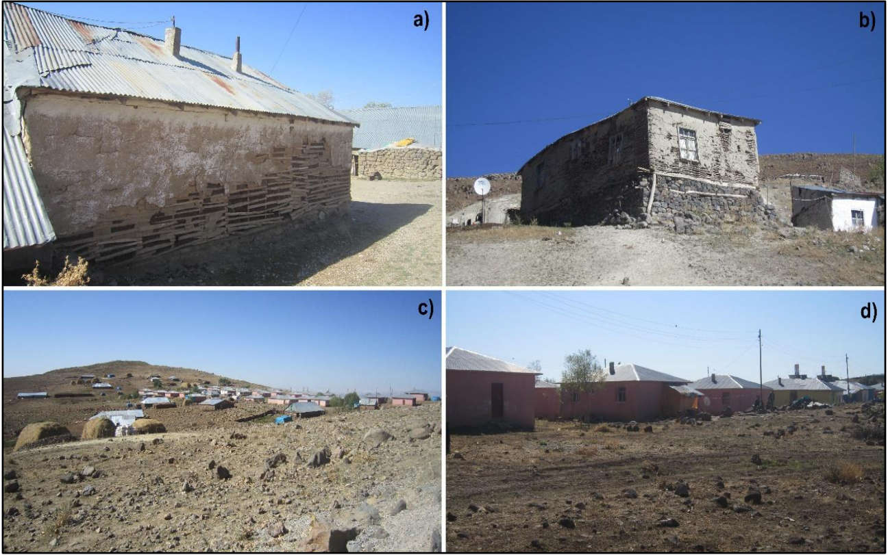
Şekil 7. 1966 Varto depreminden sonra ahşap iskelet ve çamur dolgu kullanılarak yapılan evler (a. b). Bu depremden 36 yıl sonra 2002 yılında tamamlanan afet evleri (c. d). Kırsaldan yaşanan göç nedeniyle bu evlerin bir bölümü kullanılmamaktadır
