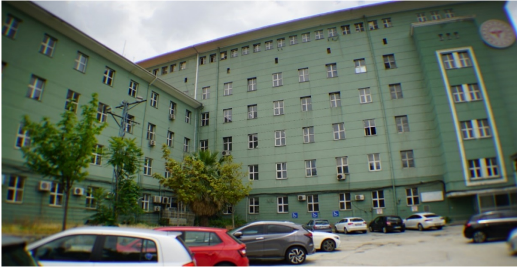
Foto. No. 4- Memleket Hastanesi Yan Cephesi (Ağustos 2022)
