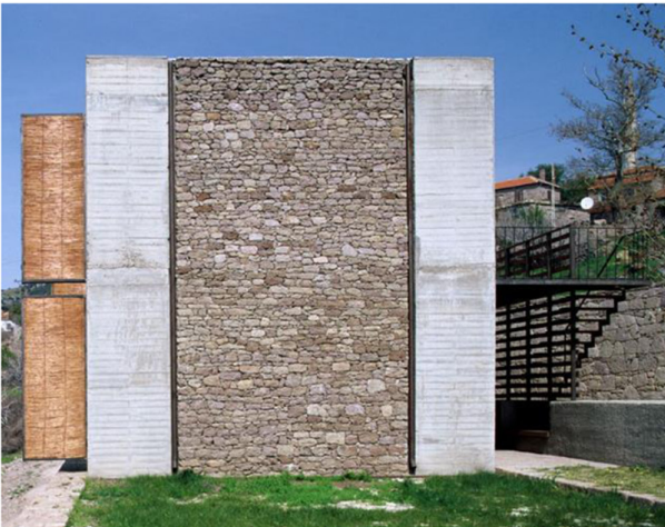
Şekil 5a, b. B2 Evi Yerel Malzeme Kullanımı ve Yığma Taş Sistemi (Emden, 2021a).
