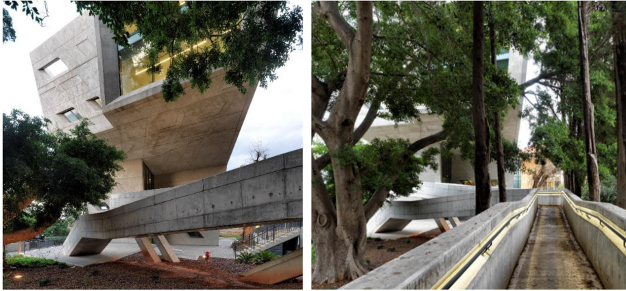
Şekil 18a, b. Issam Fares Enstitüsü'nün Yeşil Dokuyla Uyumu (Emden, 2021c).
