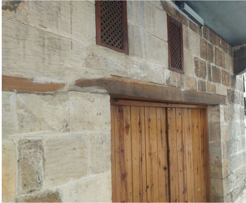
Şekil 9. Açıklık boyutu fazla olmasına rağmen hasar görmemiş bir duvar (An undamaged wall despite the large opening size)
