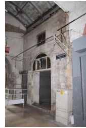
Fot.8: Alacacilar Arastasi, kuzey kapısı
