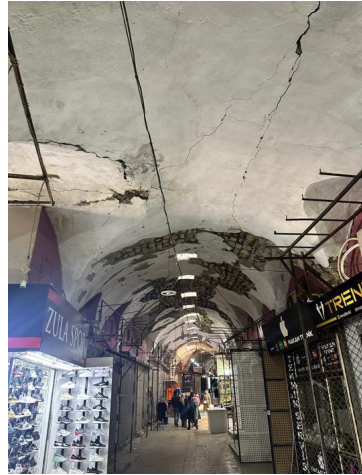
Fot.32: Maraş Kapalı Çarşısı, 6 Şubat 2023 depremi sonrası Bezirgânlar Arastası, güney koridoru (İ. Demirkol Bayrak)
