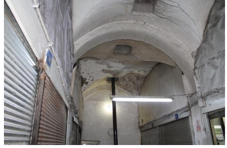
Fot.22: Maraş Kapalı Çarşı, Alacacıklar Arastası kuzey bölümün çapraz tonoz örtüsü
