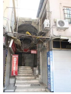
Fot.12: Maraş Kapalı Çarşı, batı cephenin ortasına açılan kapı
