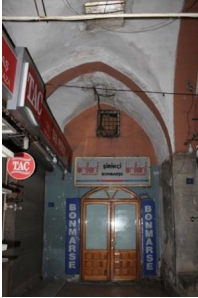
Fot.5: Maraş Kapalı Çarşı, Yeni Bedesten kapısı
