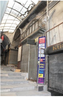
Fot.13: Maraş Kapalı Çarşı, batı cephenin kuzey köşesine açılan kapı
