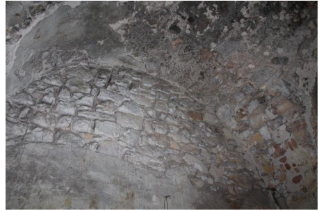
Fot.26: Maraş Kapalı Çarşı, Alacacıklar Arastası, güney bölüm örtü sisteminde özgün taş örgü
