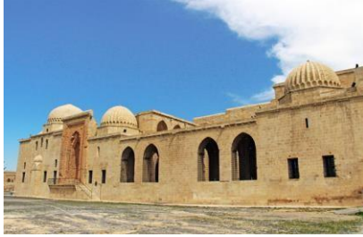
Fot. 7 Mardin Kasımiye Medresesi Güney Cephesi
