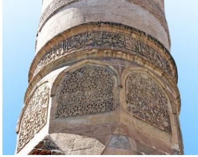
Fot. 11 Diyarbakır Safâ Camii Minaresi Pabuçta Geometrik Pano
