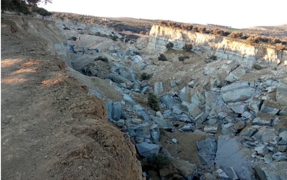
Fotoğraf 4. 6 Şubat Kahramanmaraş depremleri ile Tepehan köyü yakınında oluşan kütle hareketi (Heyelan) içerisinde kumtaşı, killi kireçtaşı, kilitaşı ve marnlardan oluşan birim içerisinde derinliği yer yer 20 m'yi bulan yarıklar (doğuya bakış) ve devrilmeler şeklinde gerçekleşen daha küçük ölçekli kütle hareketleri.
