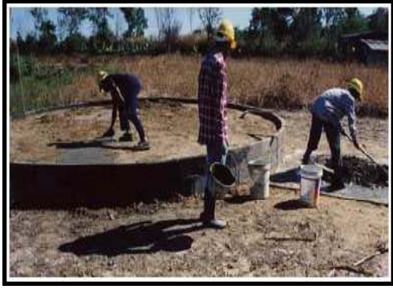
Şekil 2. Beton kaidenin Hazırlanması
