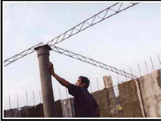
Şekil 9. Çatı Makaslarının Montajı
