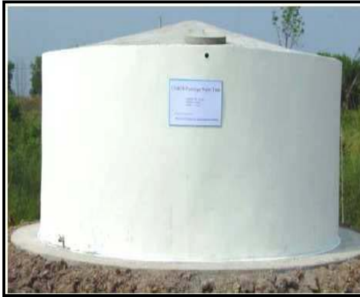
Şekil 13. Tamamlanmış Ferrocement Su Deposu
