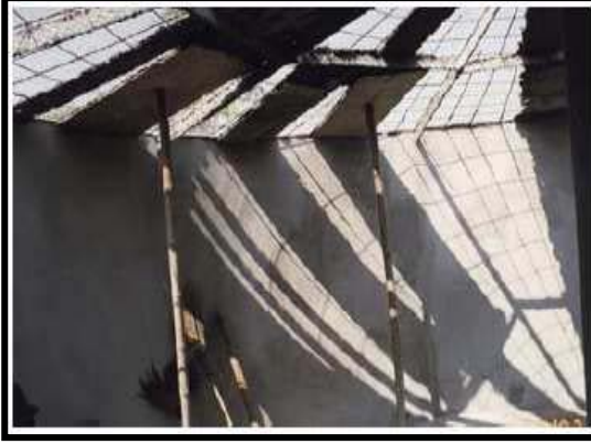
Şekil 11. Çatı İçin Geçici Kalıp
