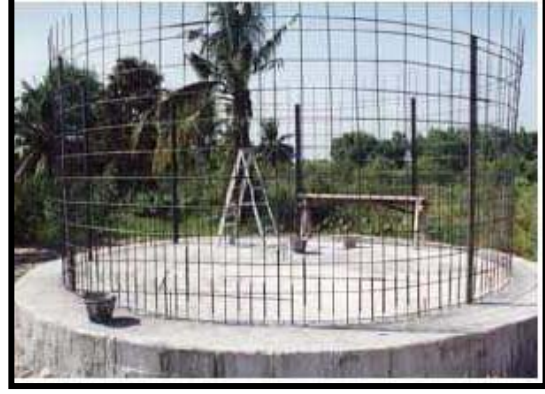
Şekil 6. Dikey Güçlendirme Çubukları
