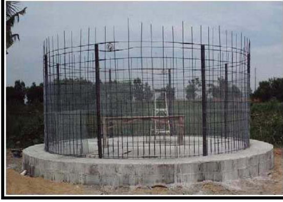
Şekil 5. Takılmış Hasır Tel
