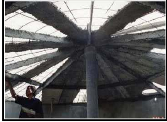
Şekil 12. Çatının Sıvanması
