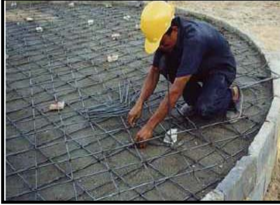
Şekil 3. Taban Döşemesi İçin Çubuk
