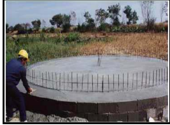
Şekil 4. Döşemenin Dökümü
