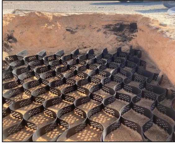
Şekil 4. Geohücrenin Deney Alanına Yerleştirilmesi
