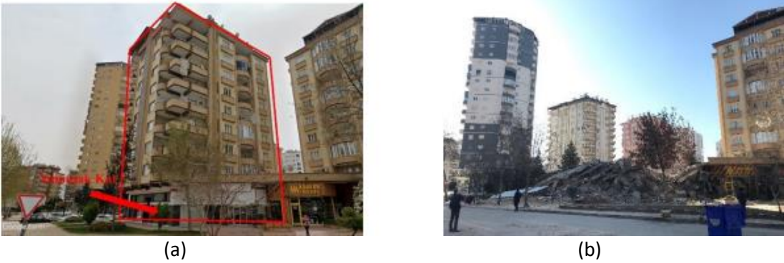
Şekil 18. Gaziantep Batıkent Mahallesinde bulunan binanın deprem öncesi ve sonrası görüntüleri (BTÜ, 2023, s.48)
