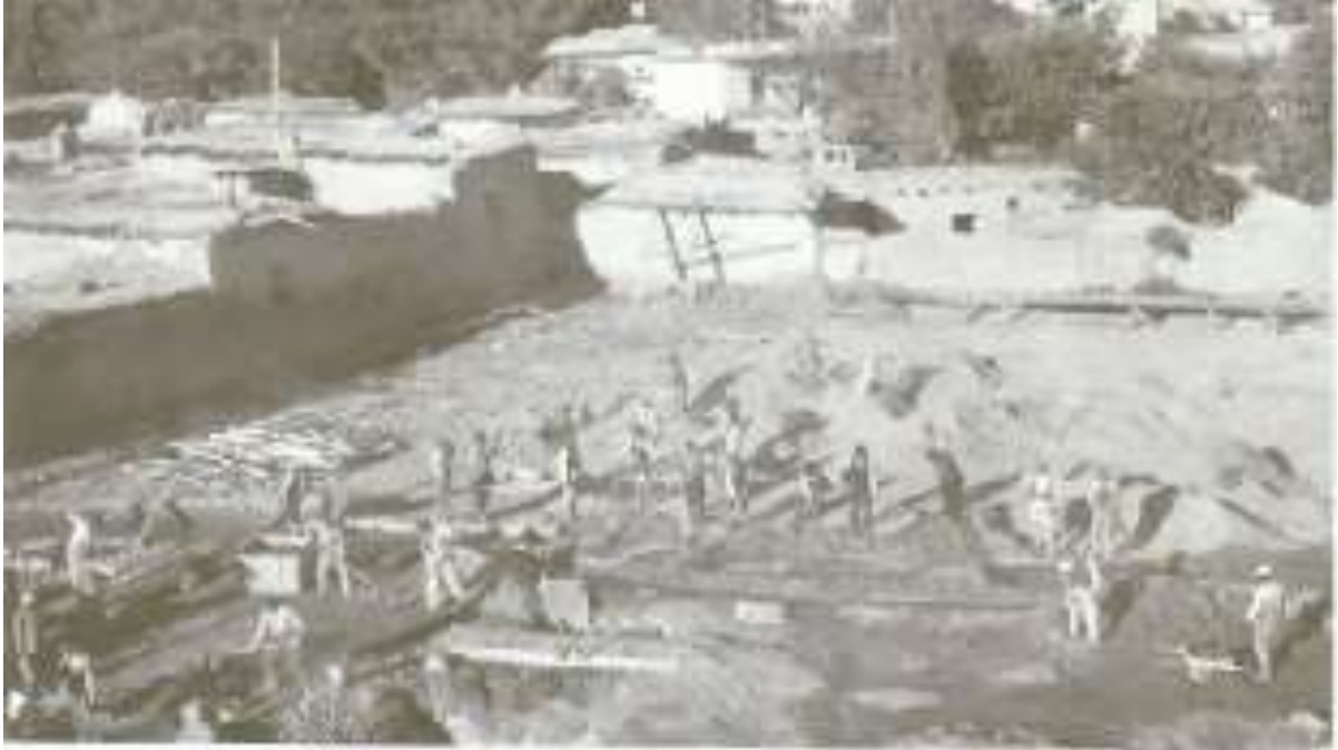
Şekil 20. Hastane inşaatı (1945) (Foto Renk Arşivi)
