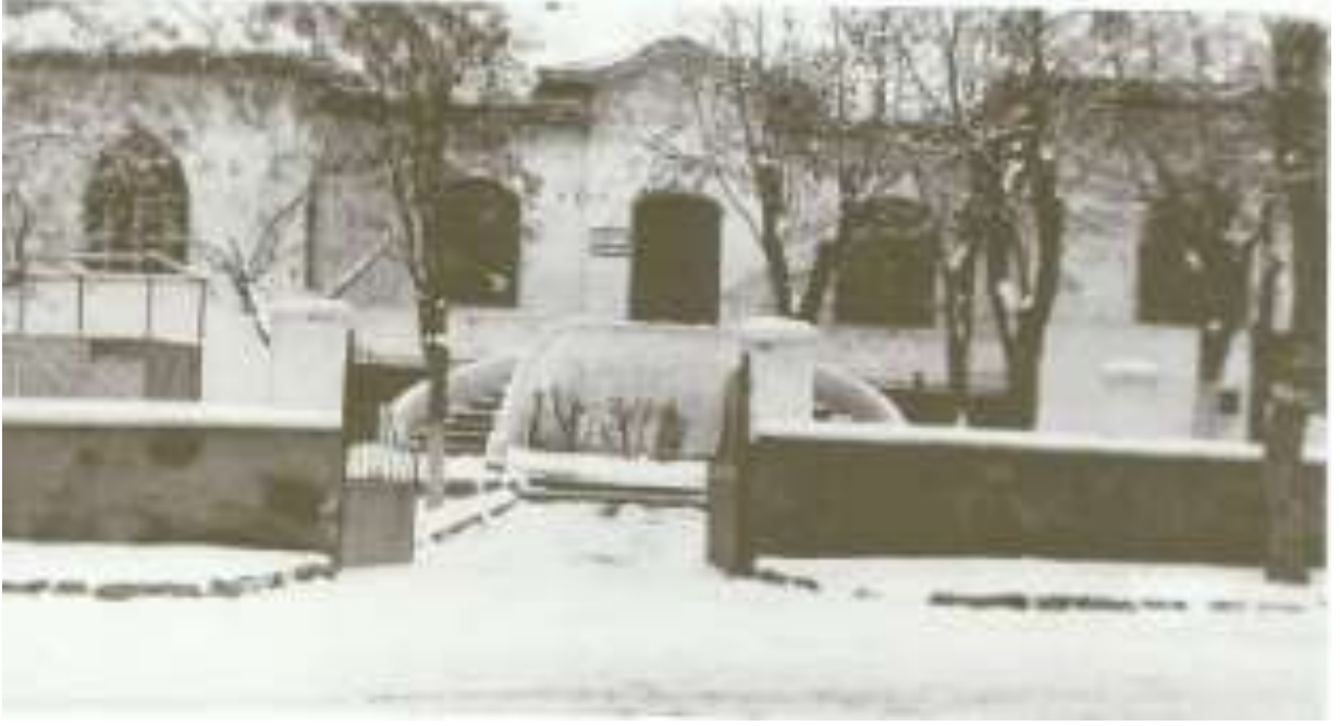
Şekil 19. Askerlik Şubesi'nin giriş cephesi (M. Vehbi Uysal Arşivi)
