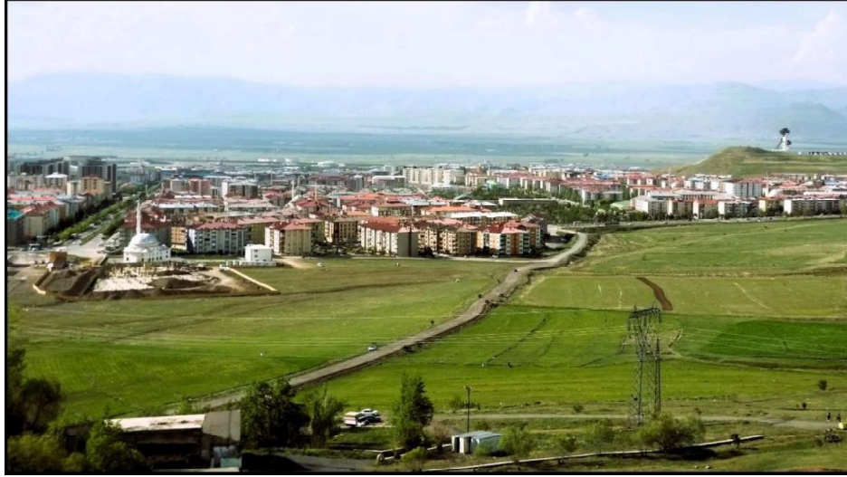
Fotoğraf 1: Müftü Solakzade Mahallesi (Çekim yönü kuzey), 21.05.2021.
