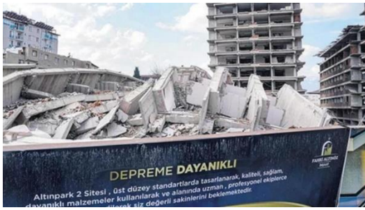
Şekil 18. Depremden sonra Altınpark 2 Sitesi (Gazete Vatan, 2023)
