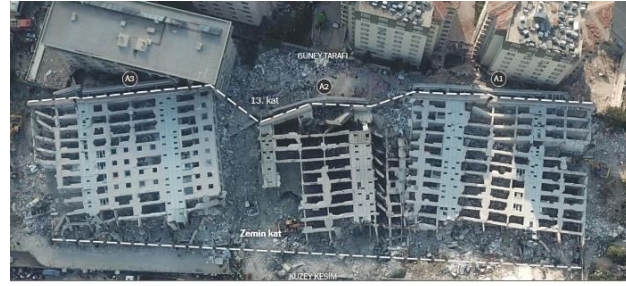
Şekil 9. Rönesans Rezidans'ın yıkılmış hali (Hubbard ve diğerleri, 2023)
