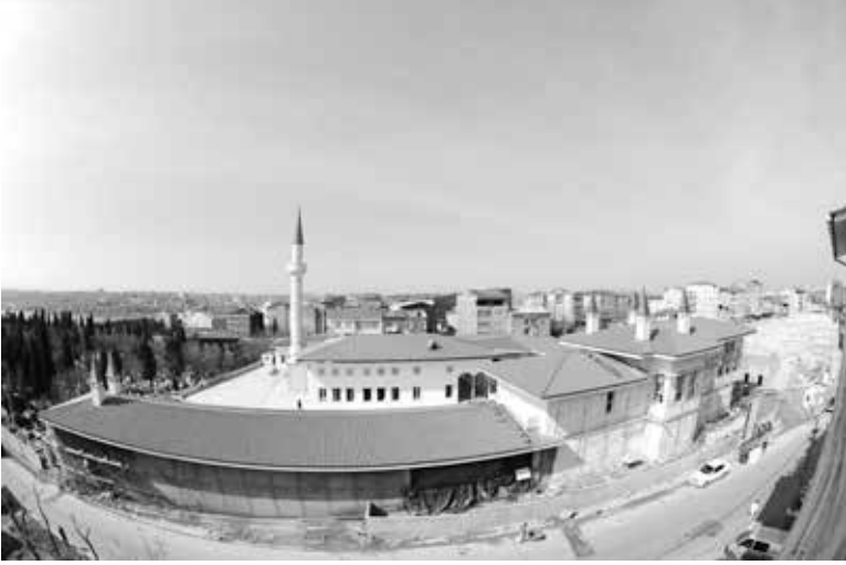
27- Okmeydanı Okçular Tekkesi yeniden inşa sonrası.
