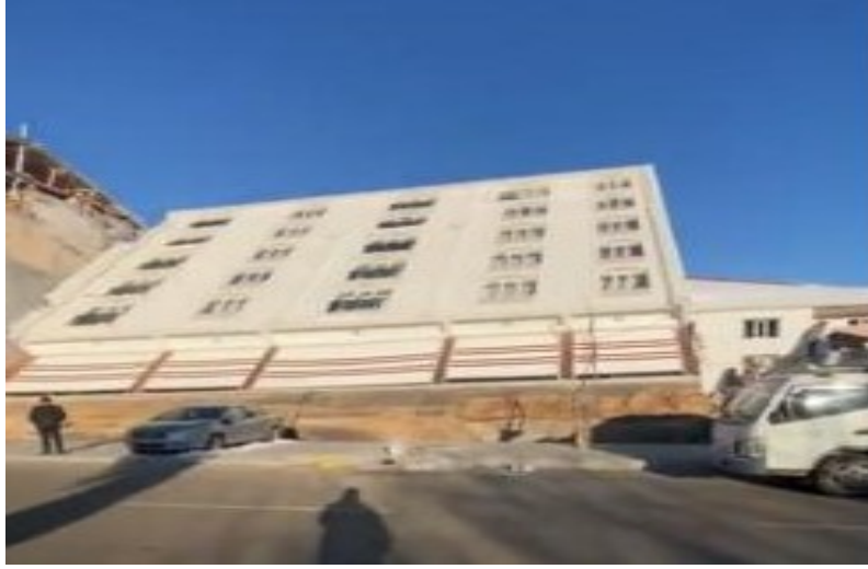
Şekil 1. Zemin Sıvılaşmasından Arkaya Yatan Bina (Adıyaman/Gölbaşı)
