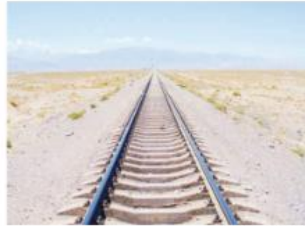
Görsel 3.19 İpek Yolu'na döşenen demir yolu (Çin)
