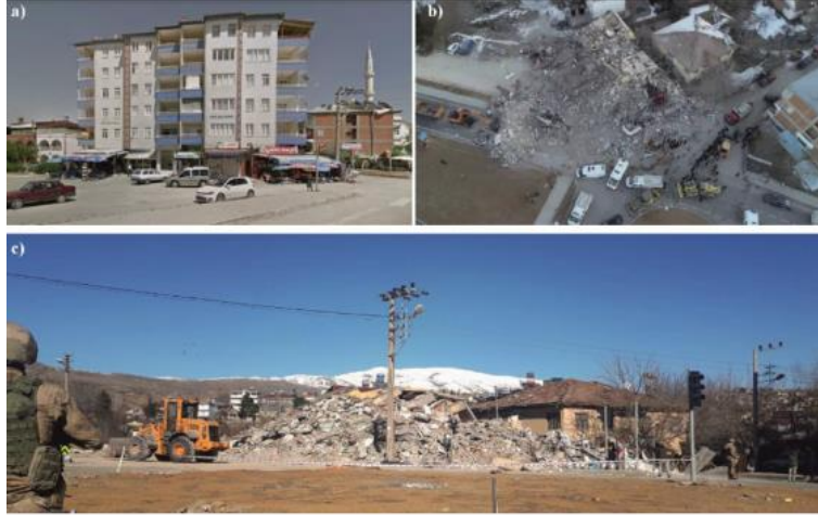
Şekil 1. Elazığ Sivrice Gezin'de yıkılan Mavigöl Apartmanı a) Depremden önce, b) Depremden sonra c) Enkaz kaldırma çalışmaları (M.T.A. Sivrice Dep. Saha Göz. ve Değ. Raporu, 2020).
