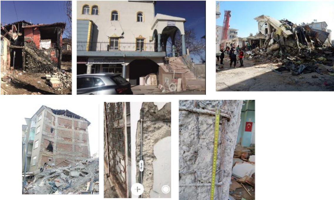
Şekil 2. Sivrice Merkez'de Hasarlı Yapılar (Hacettepe Unv Sivrice Dep. Ön İnceleme Rap, 2020)
