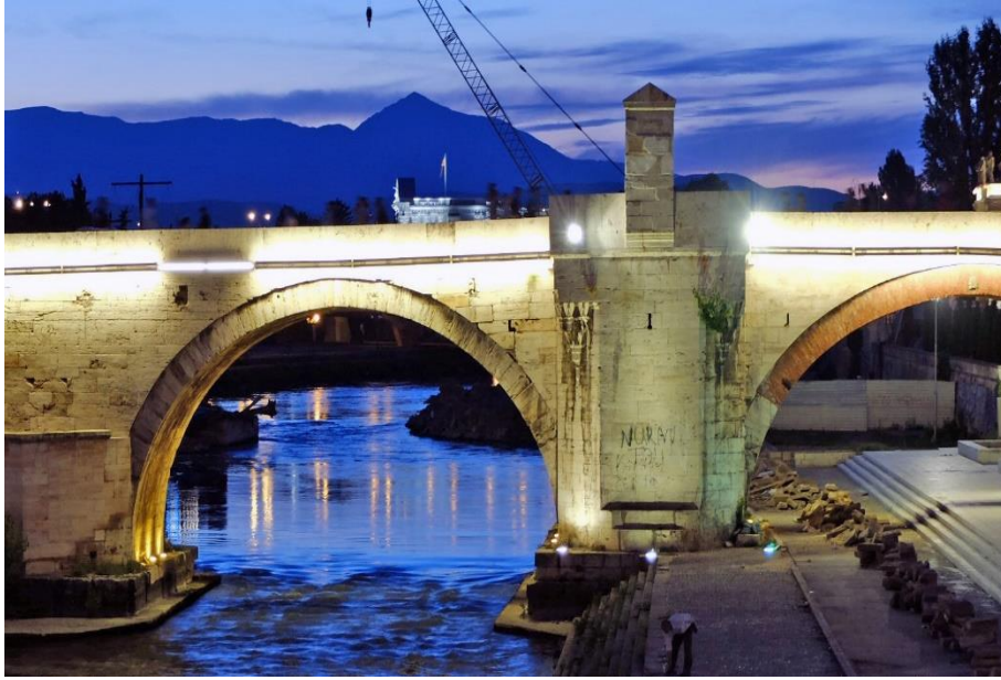
Şekil 2. Vardar Köprüsü Namazgâhına Köprü'nün Güneydoğusundan Bakış (Veysel Özbey Arşivi, 2016)
