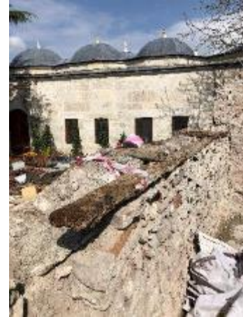
Şekil 2. Eyüp Nişanca'daki Şeyh Murad Buhari Türbesi civarında moloz taş duvar içindeki ahşap hatıl.
