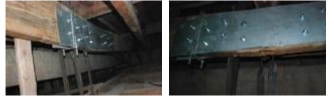
Şekil 13. Döşeme kirişlerinin onarımı.
