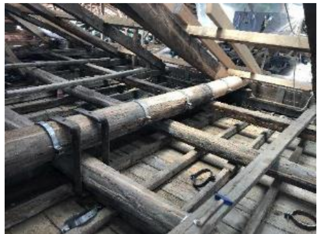
Şekil 20. Çürümüş parçanın değişimi ve takviyesi.
