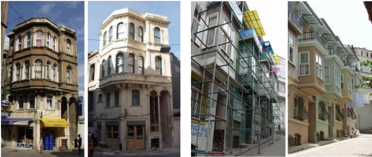
Şekil 3-4. Fener- Balat Rehabilitasyon Projesi kapsamında yapılan restorasyon uygulamaları öncesi ve sonrası fotoğrafları (İstanbul Metropolitan arşivinden aktarımla Kancafer Yurdakul, 2010).
