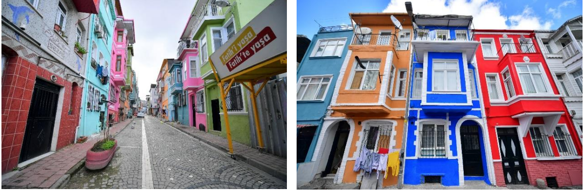
Şekil 5. Haliç Kıyısı Cephe Rehabilitasyon Projesi kapsamında gerçekleştirilen uygulamalar (Fatih Belediyesi, 2023)
