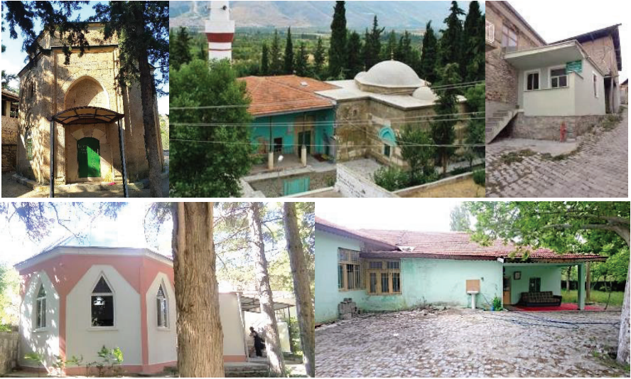
Şekil 2: Yakaören (Lavus) İsmail Dede (Yukarı Tekke) Türbesi, Senirkent Uluğbey (İlegüp) Veli Baba Türbesi, Yakaören Ümmi Nine Türbesi, Yakaören Aslan Baba Türbesi ve Alıköy Hatip Dede Türbesi
