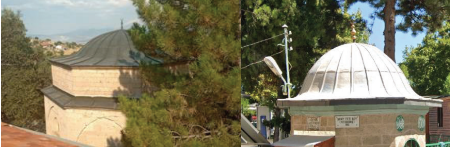
Şekil 14: İsmail Dede ve Kesikbaş Türbelerinin kurşun kaplı kubbeleri
