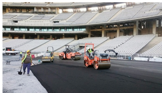
Figure 2. Removing the athletic track and paving with asphalt (Atatürk Olimpiyat Stadı'nın son hali, 2020; İstanbul Atatürk Olimpiyat Stadı Yenileme Projesi, 2019)
