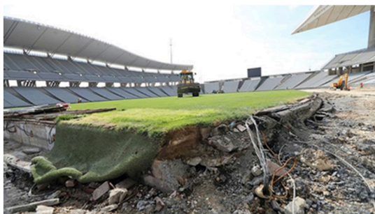
Figure 2. Removing the athletic track and paving with asphalt (Atatürk Olimpiyat Stadı'nın son hali, 2020; İstanbul Atatürk Olimpiyat Stadı Yenileme Projesi, 2019)
