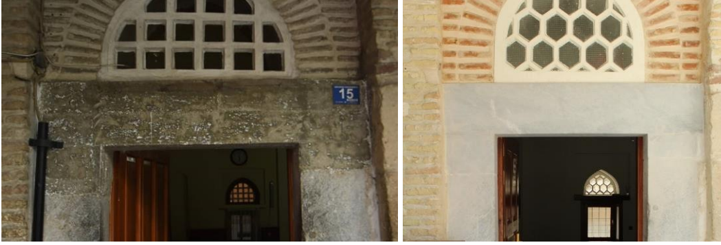
Fotoğraf 7. Mermer sövelerde temizleme öncesi (Vakıf Bölge Müdürlüğü Arşivi) ve sonrası.
