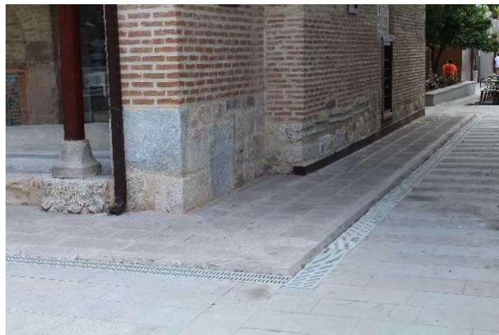
Fotoğraf 9. Drenaj uygulaması.
