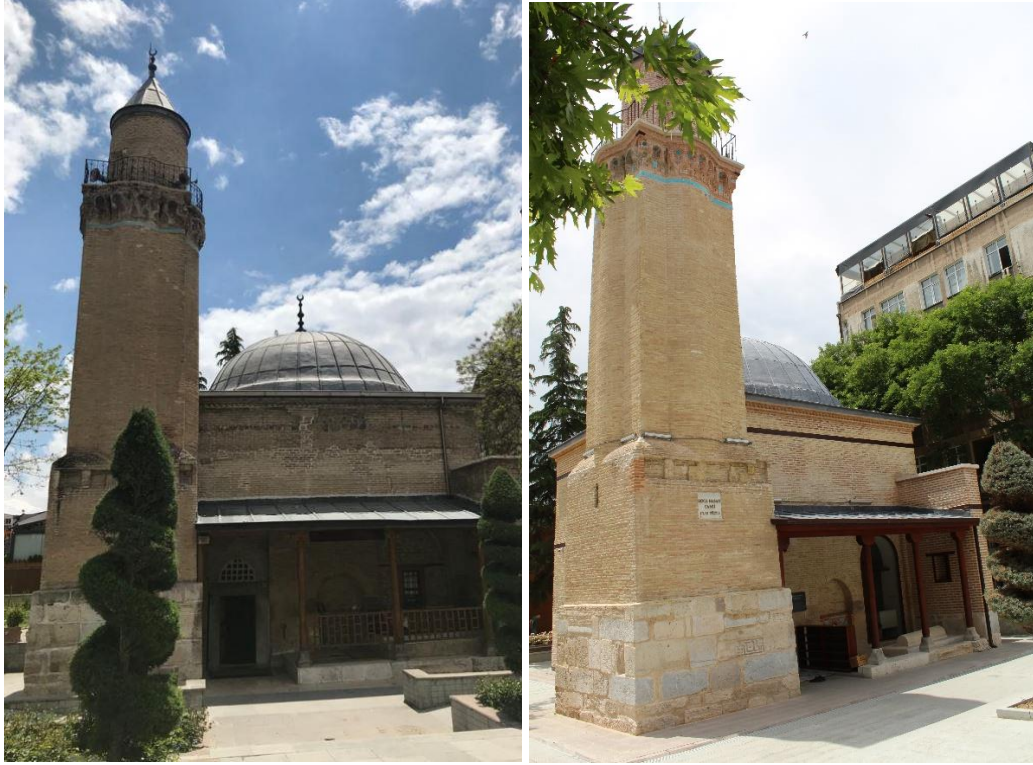
Fotoğraf 2. Mescidin onarımdan önce (Vakıf Bölge Müdürlüğü arşivi) ve sonra genel görünümü.
