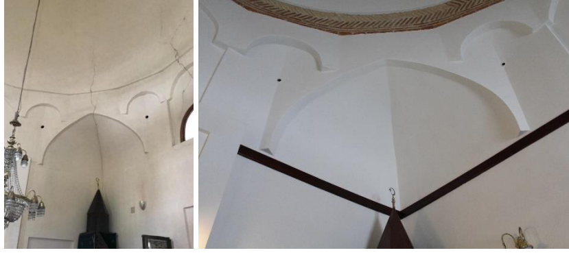
Fotoğraf 4. Kubbenin onarımdan önceki (Vakıf Bölge Müdürlüğü arşivi) ve sonraki hali.
