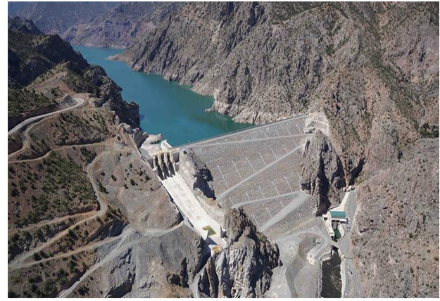
Şekil 5. Arkun barajı ve HES’leri
