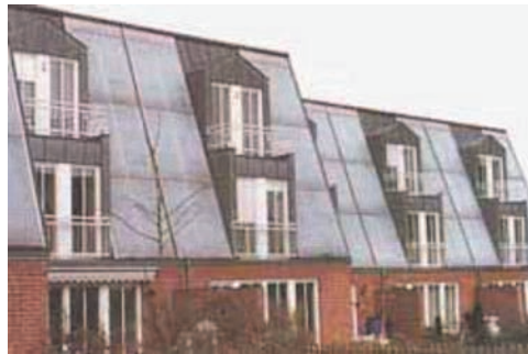
Şekil 14. Pasif-Aktif havalandırılan ve ısı yalıtımlı PV sistemleri (Krauter vd. 2000)
