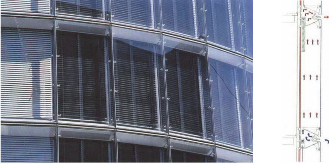
Şekil 5. Kutu tipi çift kabuklu cephe sistemi ve havalandırma kesit detayı, RWE Binası (Gür 2007)
