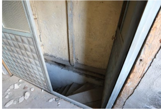
Şekil 17. Senirkent Turan İlköğretim Okulu bodrum kata iniş merdivenleri (Kişisel arşivden)
