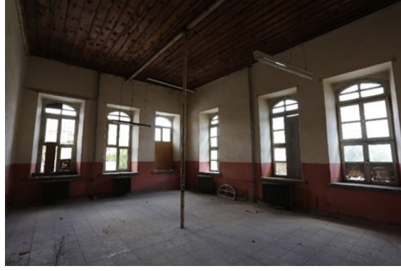
Şekil 23. Senirkent Turan İlköğretim Okulu kuzey duvarının batısında yer alan oda (Kişisel arşivden)
