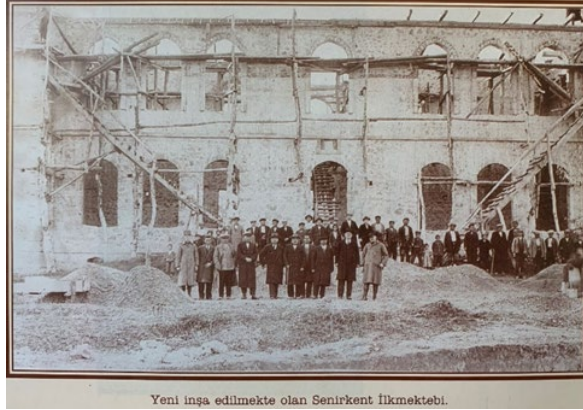
Şekil 9. Senirkent İlk Mektebi İnşaatı-1932 (Anonim, 1999, 234)
