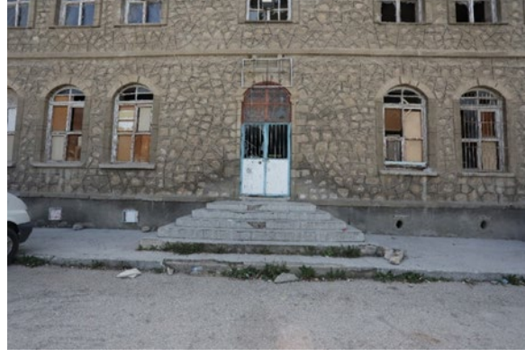
Şekil 16. Senirkent Turan İlköğretim Okulu kuzey cephe havalandırma delikleri (Kişisel arşivden)
