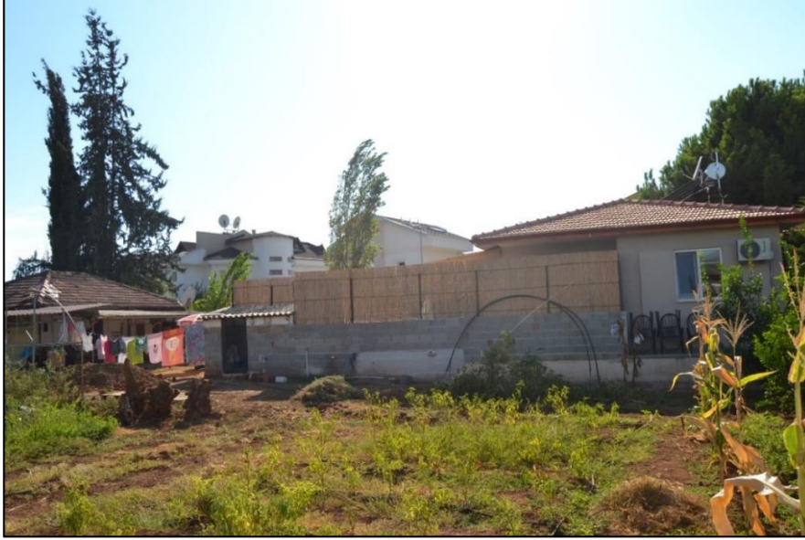
Fotoğraf 2- Fethiye'de tarım için kullanılan bir arsada kısa süreli kiralanmak üzere yapılan yeni konut örneği (solda eski köy evi, sağda özel havuzlu-izole yeni konut)
