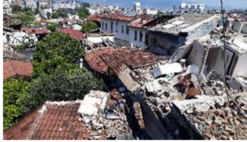
Resim 6. Deprem sonrası birbiri üzerine devrilen kütle ekleri nedeniyle ağır hasar görmüş yapı grubu (Yazar arşivi)
