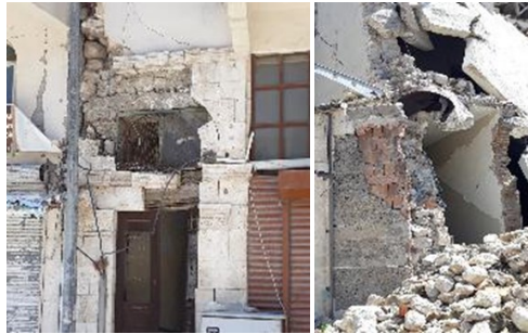
Resim 11-12. Kurtuluş Caddesi üzerinde kısmi cephe yıkımları sonrası yapılan yeni cephe inşası sırasında oluşan yapısal kusurlar (Yazar arşivi)
