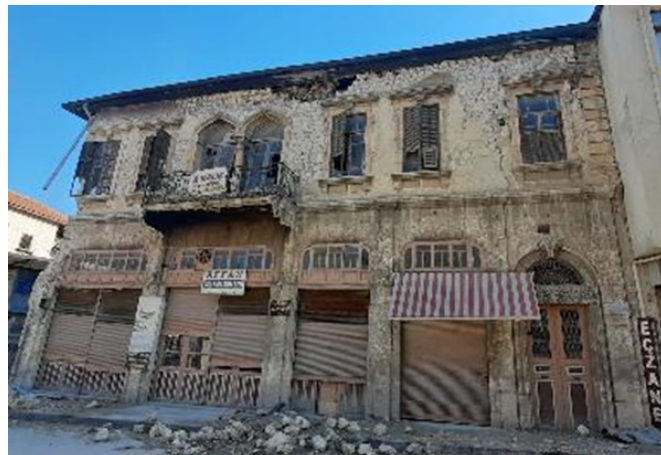
Resim 16-17. Kesme taş kaplama malzemesinin altında ortaya çıkan kötü malzeme ve duvar işçiliği kalitesine örnekler (Yazar arşivi)
