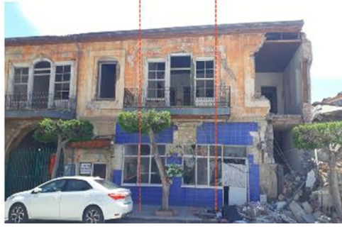
Resim 18. İskenderun’da tarihi ticari bir yapıda zemin katta dükkan açıklıklarını genişletme amacıyla yapılan müdahaleler (Yazar arşivi)
