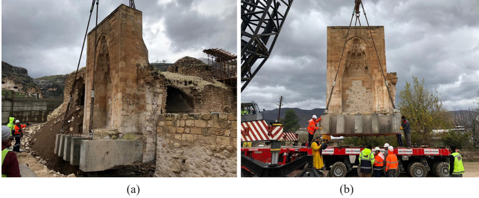
Fot. 7: a.Süleyman Han Külliyesi çeşmenin taşınması için temeline beton kiriş montajı, b. Vinç yardımıyla taşıma aracına alınması ve taşınması (Sevgi ve Yılmaz, 2022, 194.)
