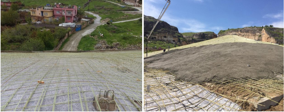
Fot. 14: Süleyman Han Külliyesi ve Koç Cami betonarme koruma kabuğunun cam elyaf donatıları
