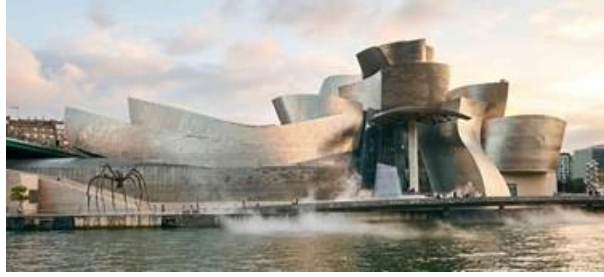
Görsel 4. Frank Gehry, 1997, Guggenheim Müzesi / Guggenheim Museum. Insapedia. Erişim: 17.12.2023. https://insapedia.com/bilbao-etkisi-nedir-marka-mimarilerin-kentlere-etkisi/
