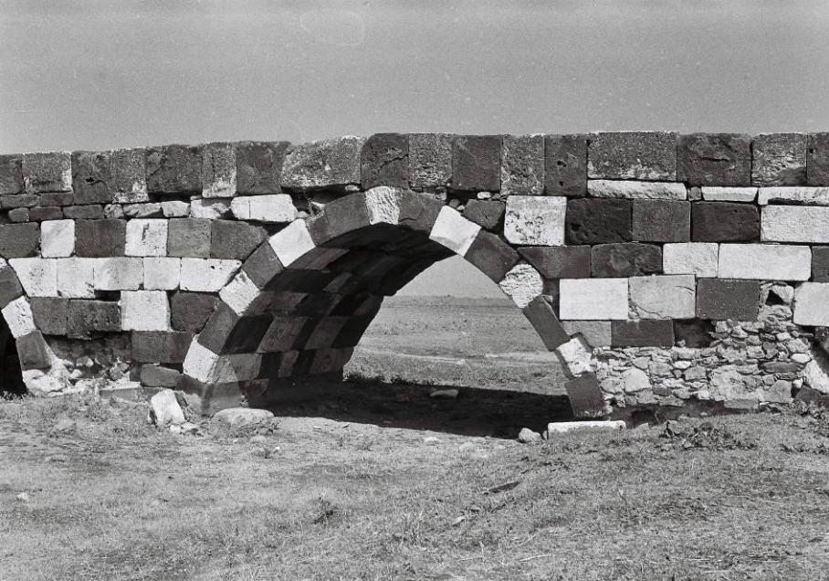
Fotoğraf 26: Köprüde Selçuklu kısmında ana gözün cephesi (1982)
