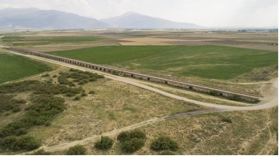
Fotoğraf 20: Kırkgöz Köprüsü, restorasyon sonrası ( https://www.afyonkarahisar.gov.tr )
