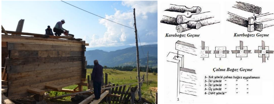
Foto. 2. Acara kırsalında modern ahşap mimaride devam ettirilen çantı tekniği (Kaya, 2019); Çantı camilerde uygulanan inşai teknikler (Fatih Orhan)
