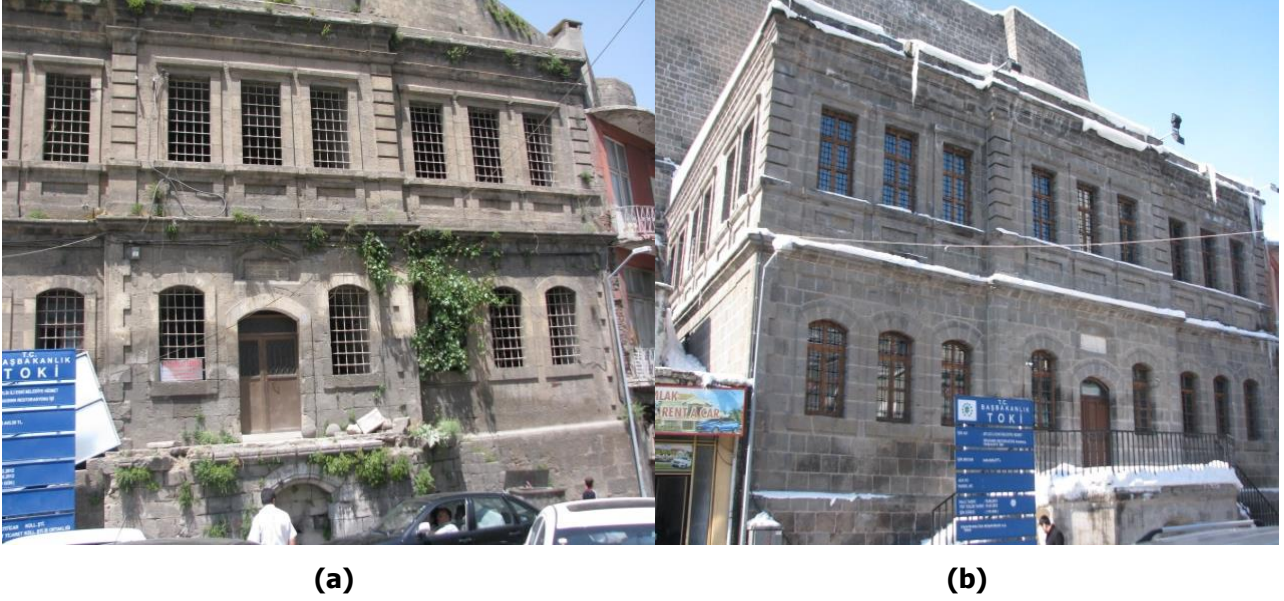
Şekil 32. Bitlis Eski Belediye Binası (a) Doğu genel görünüşü; (a) Güneydoğu genel görünüşü (b) (Kaynak: (a, b) Çalışma kapsamında yazar tarafından oluşturulmuştur, 2012).
