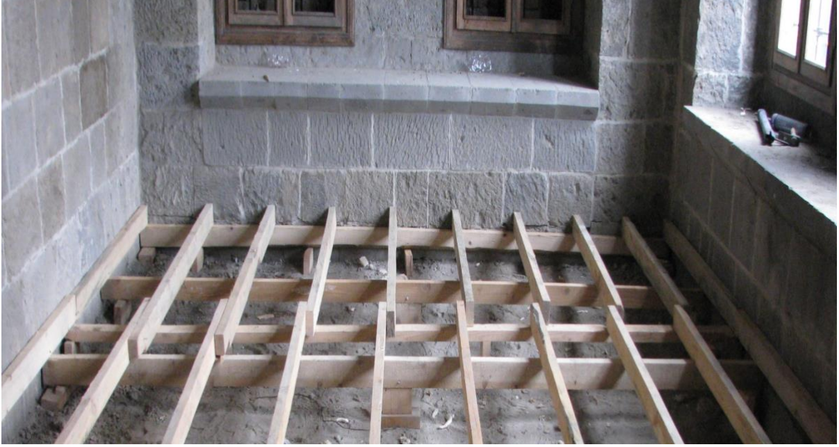
Şekil 36. Bitlis Eski Belediye Binası iç mekân zemin kaplama onarım görünüşü (Kaynak: Çalışma kapsamında yazar tarafından oluşturulmuştur, 2012).
