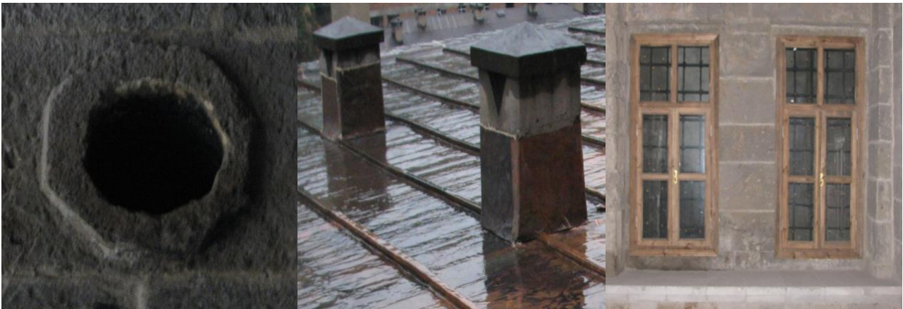
Şekil 24. Bitlis Eski Belediye Binası (a, b, c) Zemin kat iç mekân soba baca yuvası, baca ve pencere görünüşleri (Kaynak: (a, b, c) Çalışma kapsamında yazar tarafından oluşturulmuştur, 2013).
