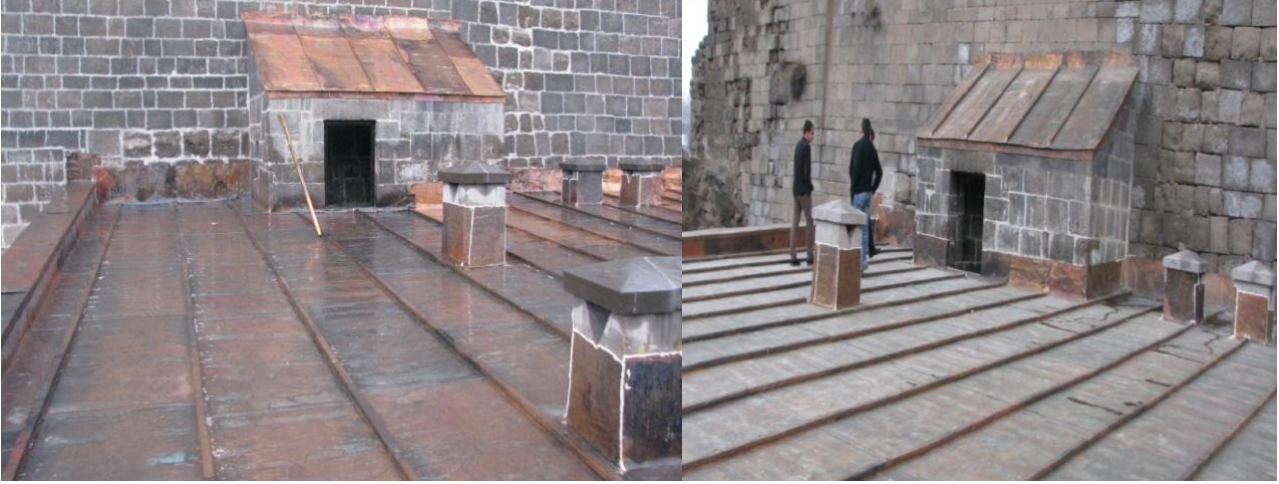
Şekil 23. Bitlis Eski Belediye Binası (a) Düz dam genel görünüşü; (b) Düz dam düz dam genel görünüşü (Kaynak: (a, b) Çalışma kapsamında yazar tarafından oluşturulmuştur, 2012).
